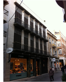
EDIFICIO DE VIVIENDAS C/Vázquez López 8. Huelva
